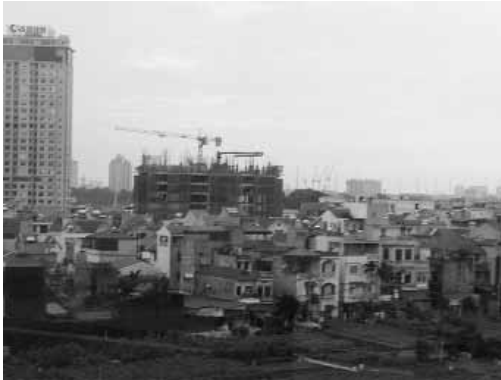
写真 1：ハノイ市の民家と工事中のビル
