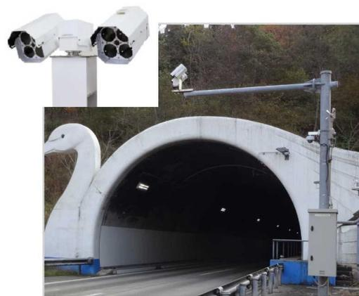
写真 1 トンネル出入口の電熱融雪を制御する積雪センサ
