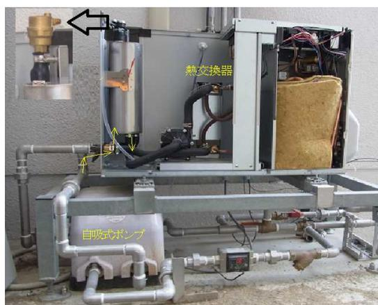
写真1 直膨式HPと逆止弁付炭酸ガス抜き弁では、プレート内部のスライム発生で、運転できなかった。
