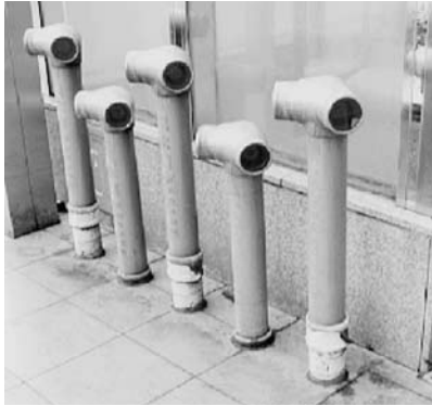
写真 - 3 地震時に給水できる 蛇口付きの消雪井戸
