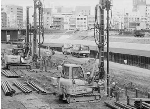
写真 - 2 熱交換杭直径14cm 長さ23m 378本の施工
