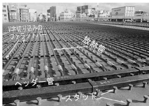
写真 - 1 幸橋での融雪用放熱管の設置
