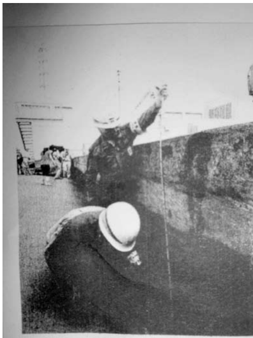
図3 1号機と2号機間の道路には、地震による陥没のため最大1.6mの段差ができた。 [参考資料(9)より引用]
