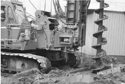
写真-2 杭打ち機オーガー先端からの ゲル材注入による孔壁保護掘削 (坂井市中学校)
