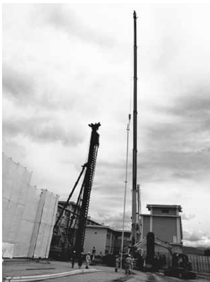
写真-3 井戸ケーシングの吊り上げ埋設
