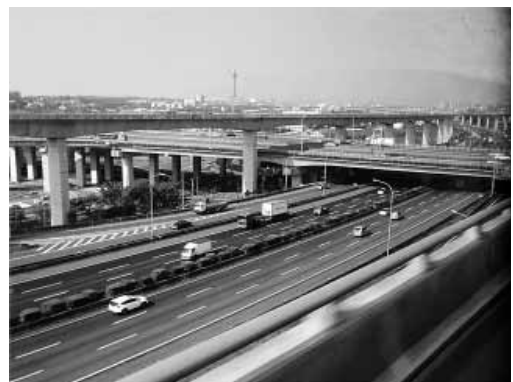
写真 18：台中市から台北市に向かうバスから撮った高速道路。高架が多く、道路はよく整備されていた。
